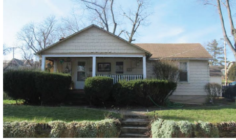
53 N. Riverview St – Existing Porch
